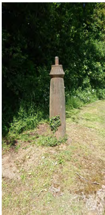
LNWR crane base
